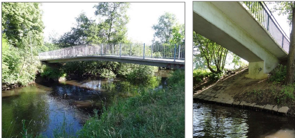
Abbildung 44: Fußgängerbrücke Schülerstieg, Station-km 8+449 (Bad Bramstedt) (Bilder: 7417, 5428, 7415)
