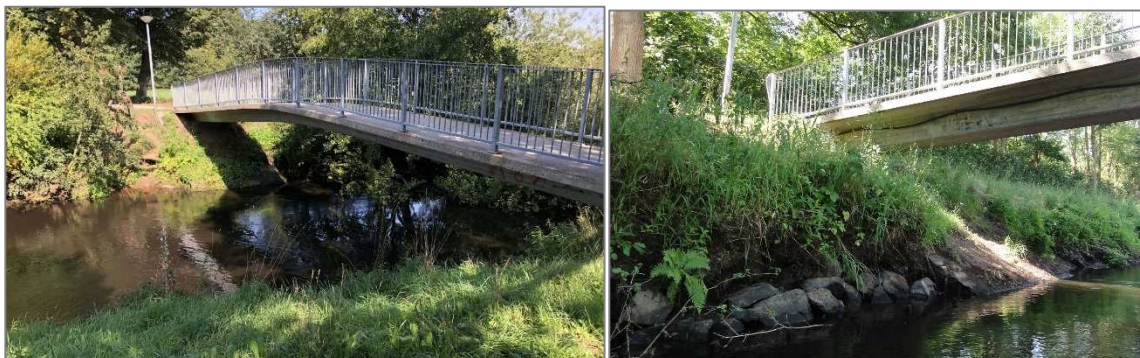
Abbildung 45: Fußgängerbrücke Wiesenstieg, Station-km 8+127 (Bad Bramstedt) (Bilder: 710gNN, 7434)
