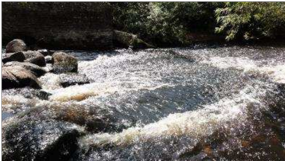
Abbildung 56: Ehemaliges Kulturstaubauwerk Station- km 5+235
