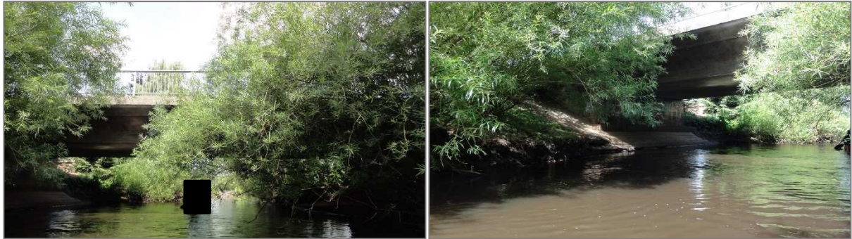
Abbildung 46: Straßenbrücke Weddelbrooker Damm, Station-km 6+305 (Hitzhusen) (Bilder: 7547, 7548)
