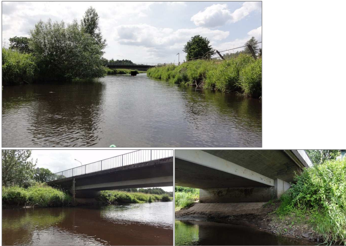
Abbildung 48: Straßenbrücke Neuer Damm (K59), Station-km 1+848 (Föhren-Barl) (Bilder: 7677, 7679, 7680)
