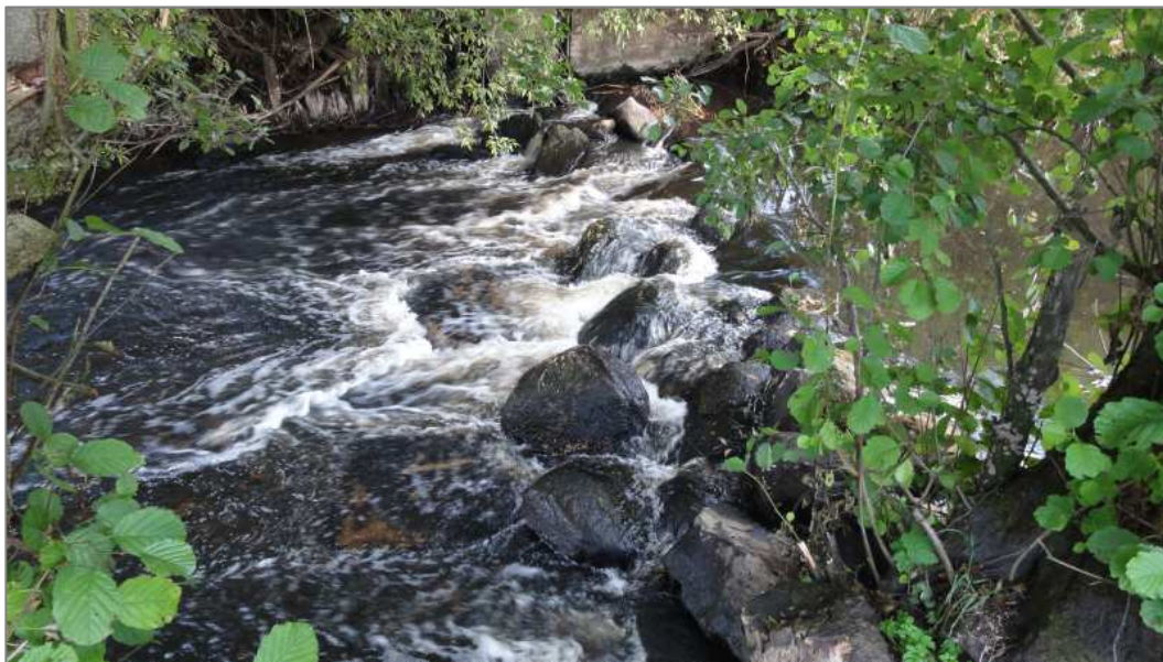
Abbildung 52: Ehemaliges Kulturstaubauwerk Station- km 6+650
