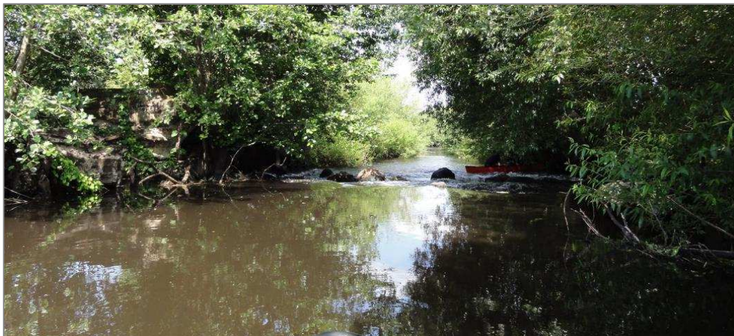
Abbildung 50: Ehemaliges Kulturstaubauwerk Station-km 6+650 (Blickrichtung stromabwärts)
