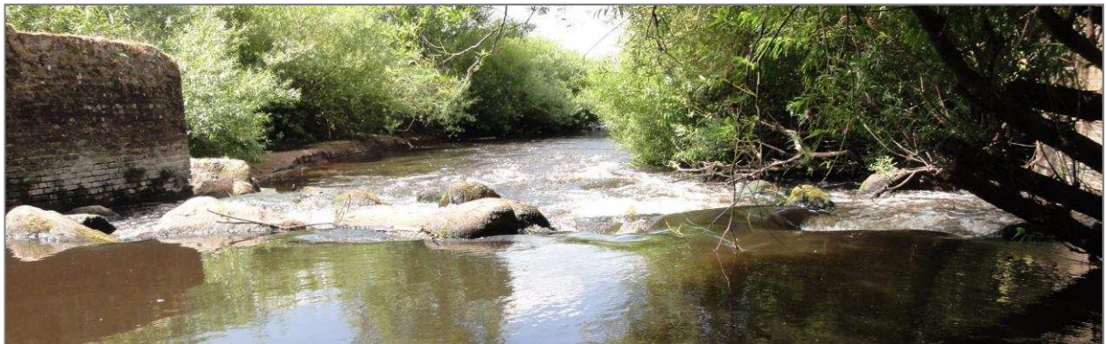
Abbildung 54: Ehemaliges Kulturstaubauwerk Station-km 5+235 (Blickrichtung stromabwärts)
